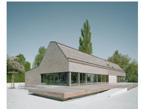
35 Der Neubau ist den historischen Pfahlbauten nachempfunden
