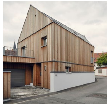
14 Das Wohngebäude nimmt die historische Straßensituation auf
