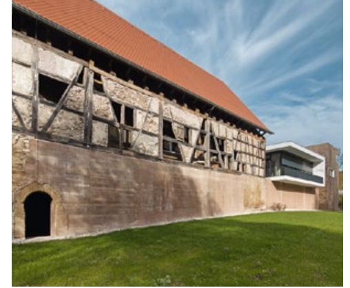
26 Neue Elemente ergänzen den historischen Bestand
