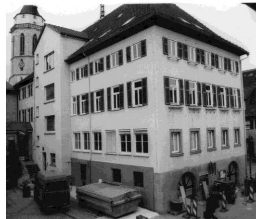
Der Hinterhof des Rathauses vor der Sanierung, Stadtarchiv Balingen
