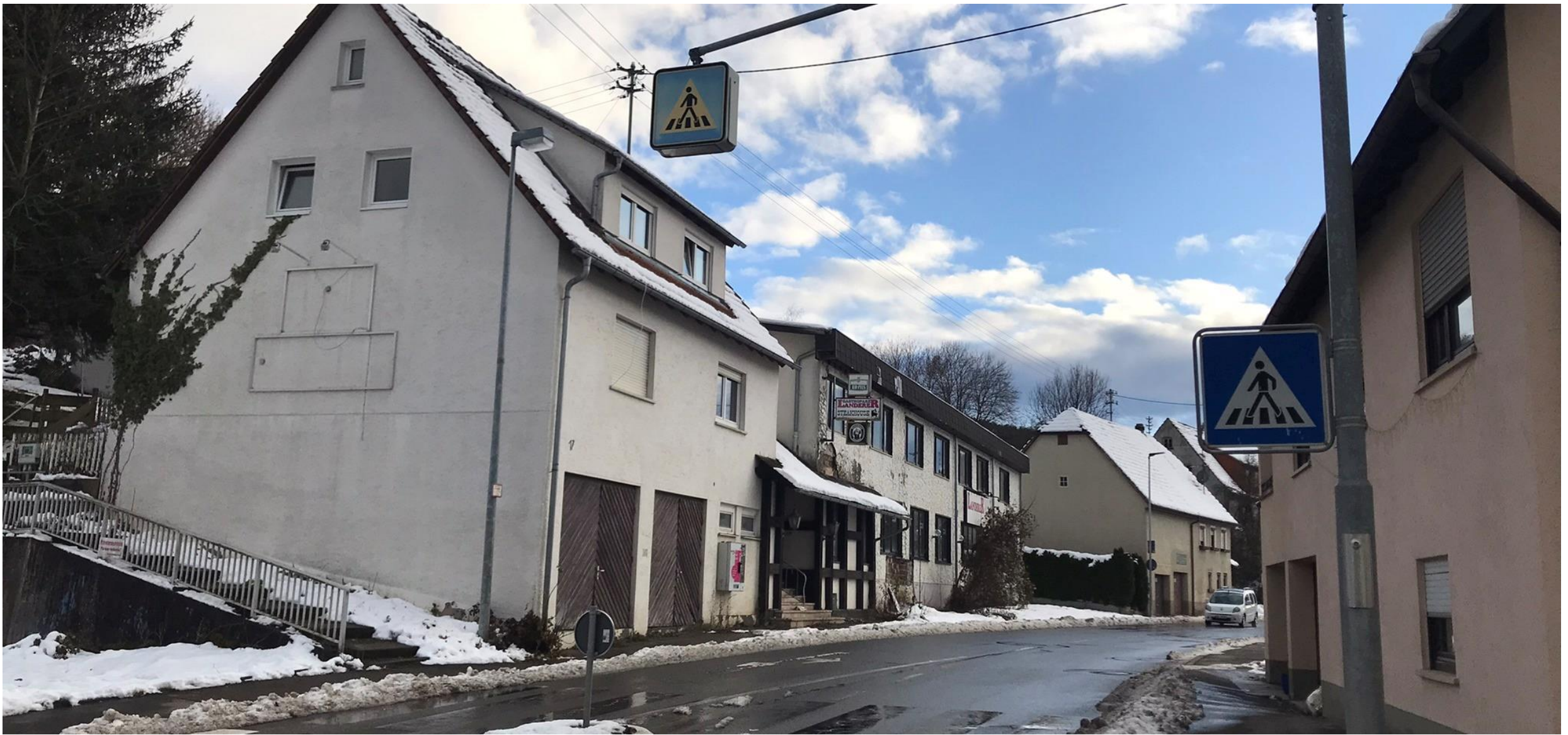
Nachverdichtung im Ortskern – ehem. Landerer-Areal
